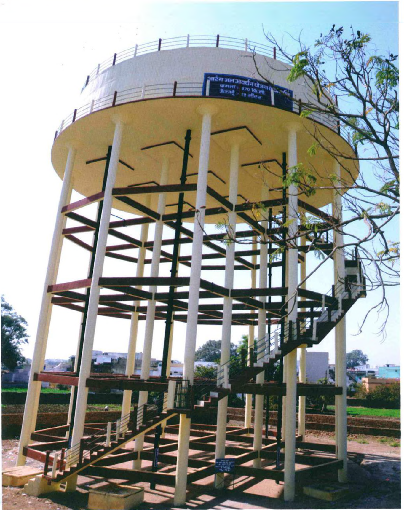
आरंग आवर्धन जलप्रदाय योजना, जिला सच्यपुर उच्चस्तरीय जलागार क्षमता 870 कि.ली., स्टेजिंग 19 मीटर
