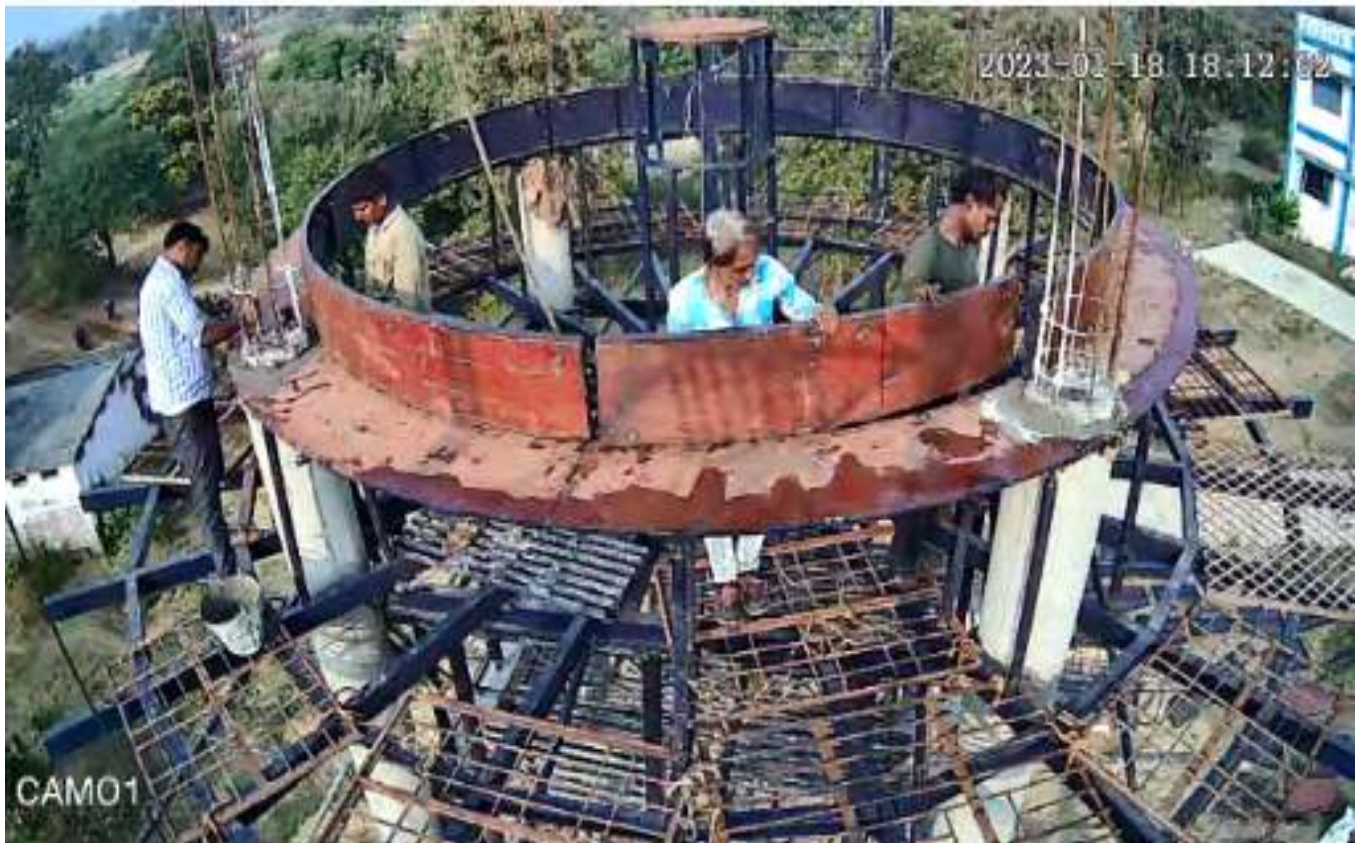
जल जीवन मिशन अंतर्गत निर्माणाधीन उच्चस्तरीय जलागार ग्राम - छुरिया डोंगरी, विकासखंड- छुरिया, जिला राजनांदगांव
