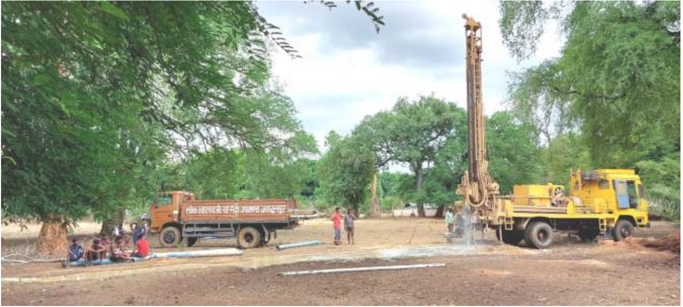
ग्राम-सुलेंगा, विकासखंड-नारायणपुर, बसाहट- गायतापारा जिला-नारायणपुर नलकूप खनन कार्य
