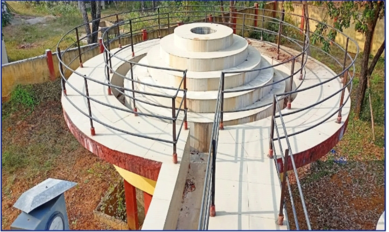
बीजापुर आवर्धन जलप्रदाय योजना जिला बीजापुर के अंतर्गत निर्माणाधीन कैसकेड एरीयेटर
